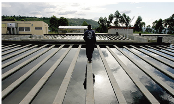
UNE CENTRALE DE TRAITEMENT DE L'EAU POUR LUTTER CONTRE LE CHOLÉRA - KALÉMIE, RDC
