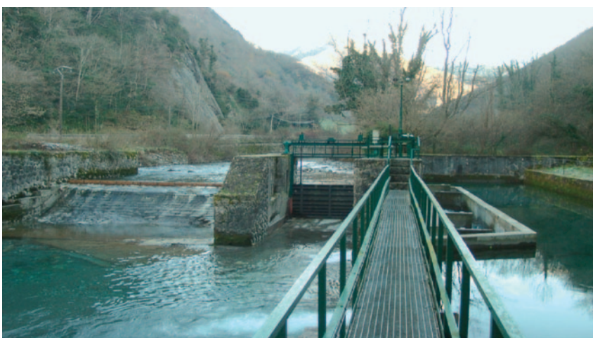
Modifications du lit du cours d'eau de montagne liées à la présence d'un barrage
