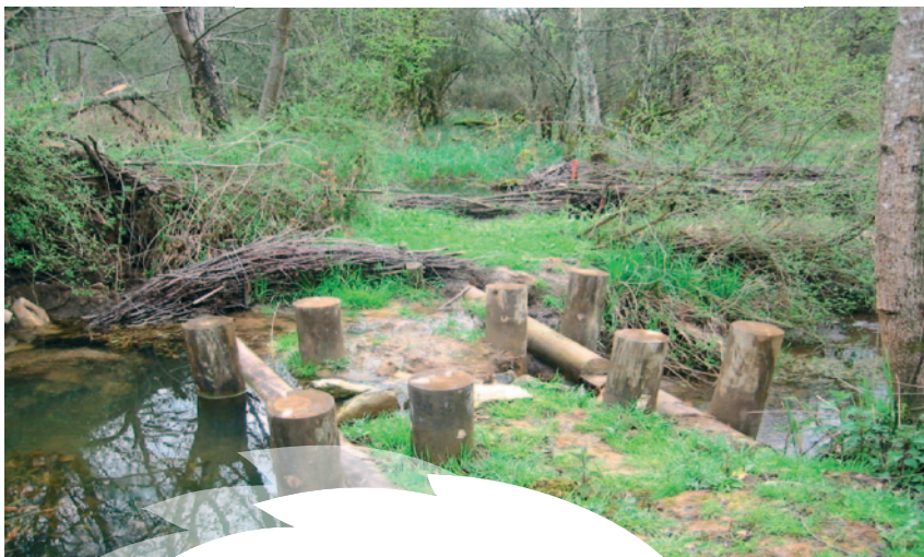
Création de barrage sur des drains principaux pour restaurer l'alimentation hydrique du milieu
