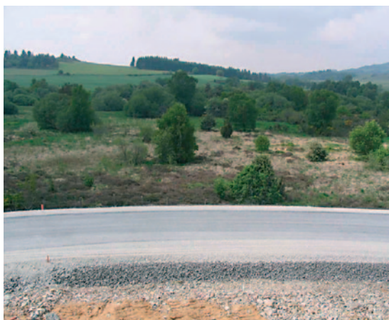
Infrastructure routière en remblai sur une tourbière
