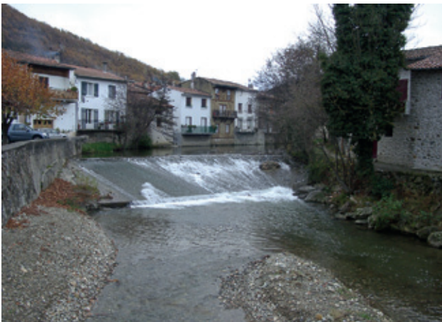
› L'Alsès : seuil transversal.
