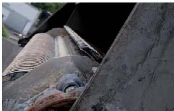
Dégrilleur à dents sur effluent laitier
