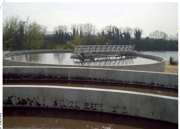
Clarificateur d'une station d'épuration
