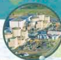
CNPE du Blayais : refroidissement et production
