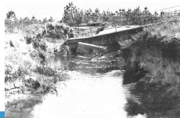
Destruction d'un pont à La Teste en 1967 du fait de l'érosion régressive
