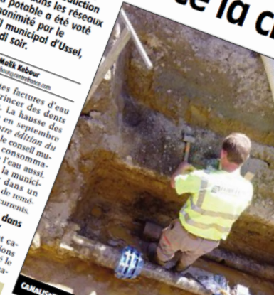
CANALISATIONS. 20 km de réseau vont être traités sur deux ans. DR
