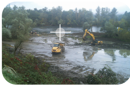
Pendant les travaux
