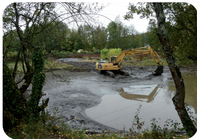
Création de rigoles de ressuyage
